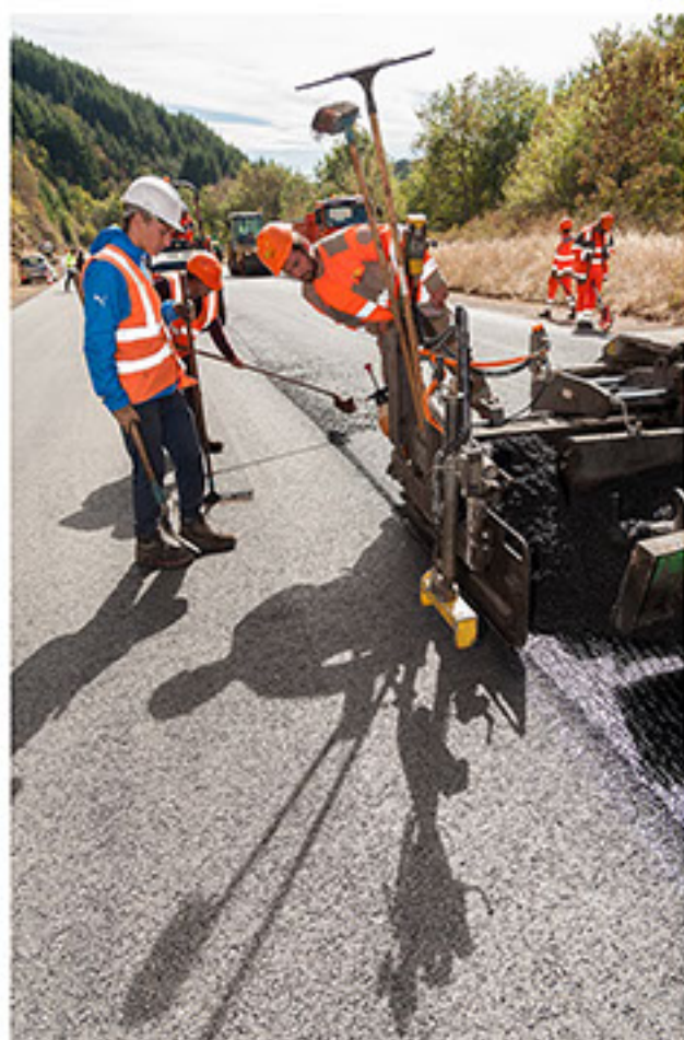
Enrobé à froid RD809 en Lozère (Colas) © Laurent FABRY - Studio ARLY PHOTOGRAPHY http://bit.ly/2CmfvfP
