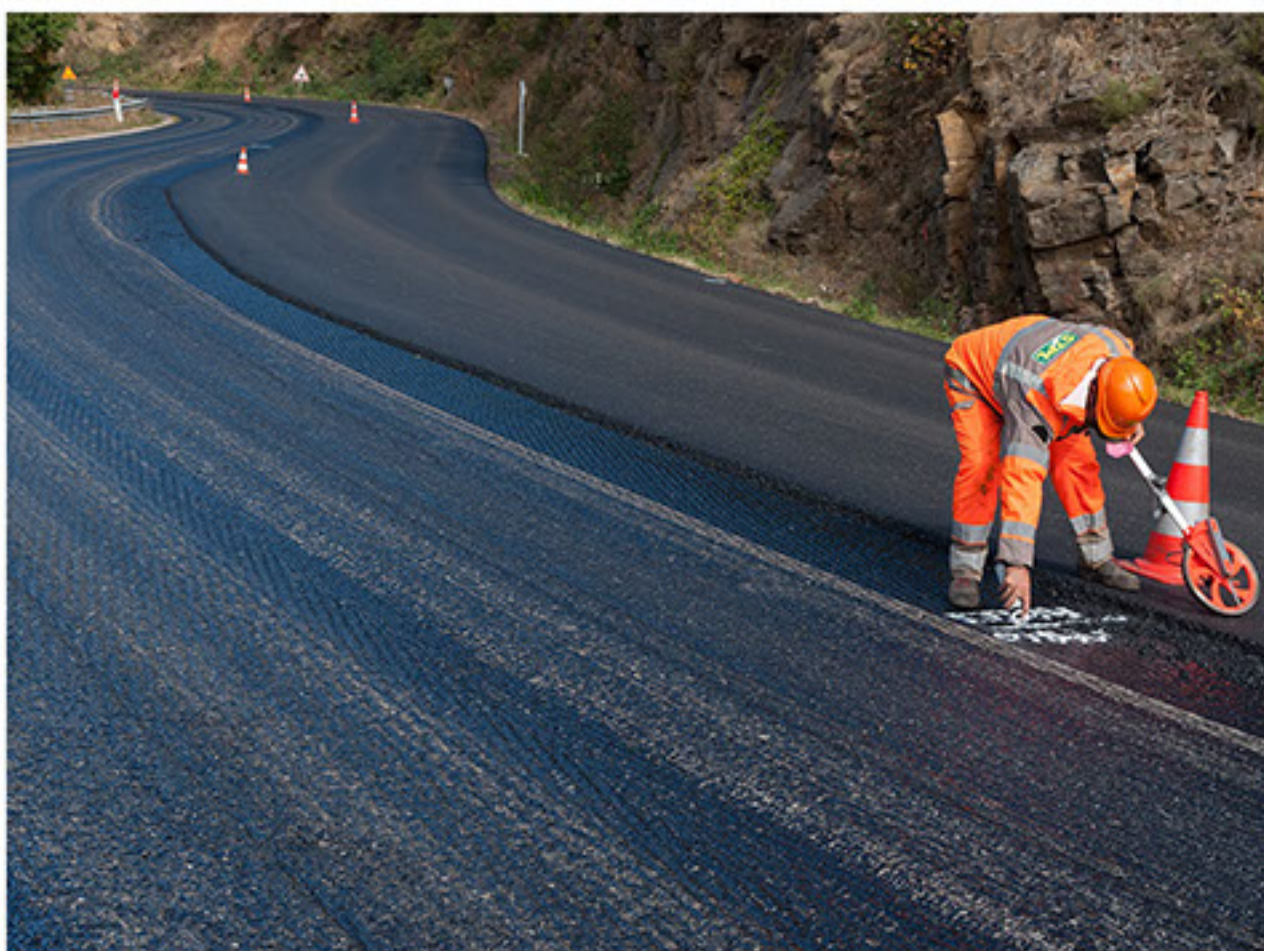
Enrobé à froid RD809 en Lozère (Colas) © Laurent FABRY - Studio ARLY PHOTOGRAPHY http://bit.ly/2CmfvfP
